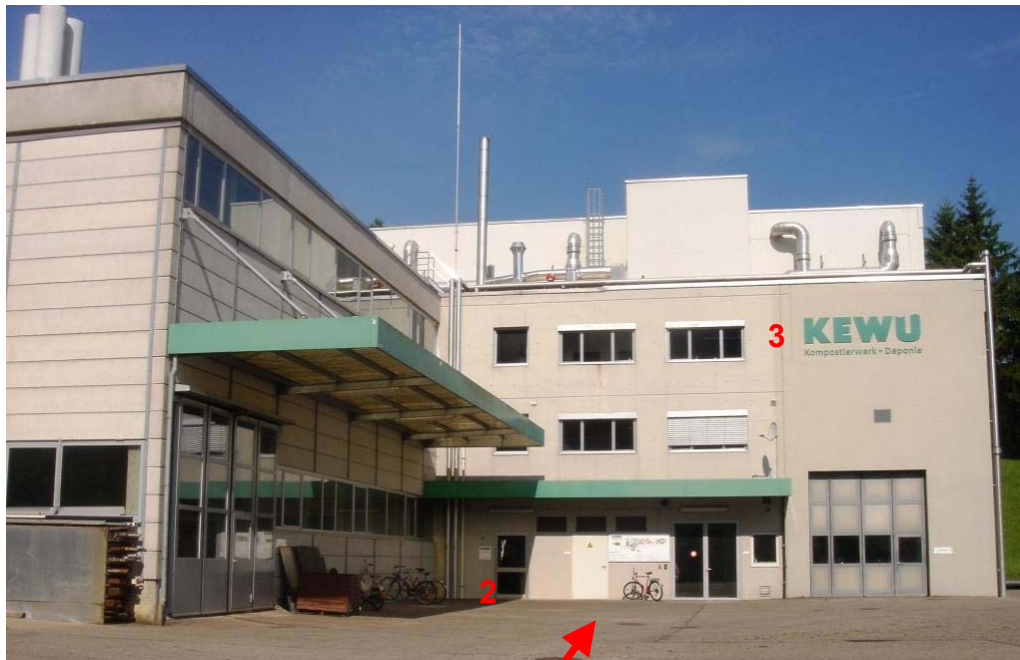
unten: Sicht aus Richtung Einfahrtstor
