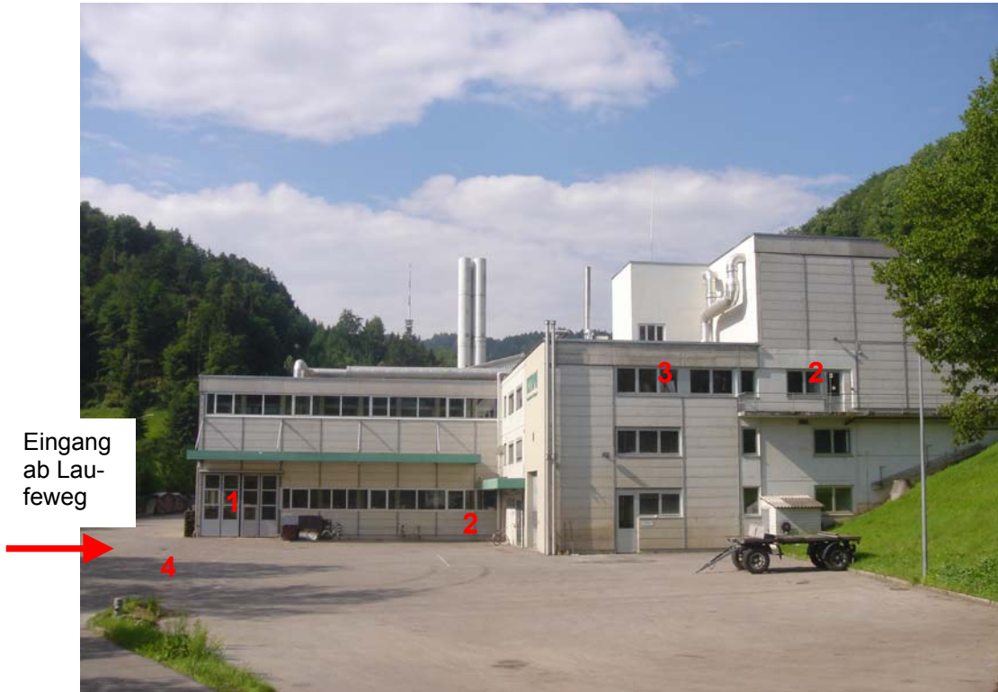
oben: Sicht auf Betriebsgebäude aus Richtung Hauptstrasse Bolligen – Krauchthal gegen Bantiger
